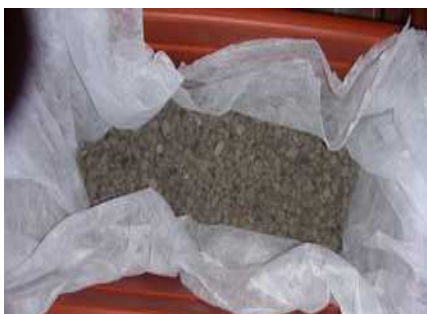
L'argilla espansa viene introdotta nel sacco formato dal tessuto non tessuto
