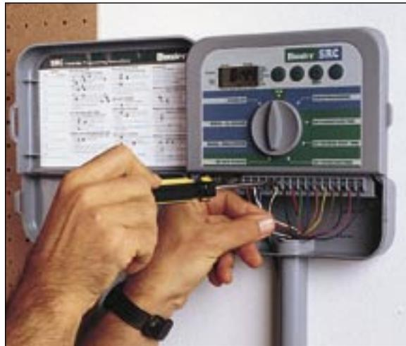
Usare dei cavi colorati per collegare le valvole al programmatore. Prevedere un cavo per ogni valvola più un cavo comune a tutte.
