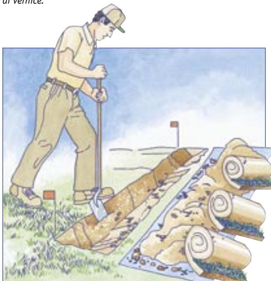
Posizionare anzitutto un telo di plastica per deporre il prato arrotolato e poi scavare una trincea profonda 25-30 cm per la canalizzazione principale e 15-25 cm per le canalizzazioni secondarie.
