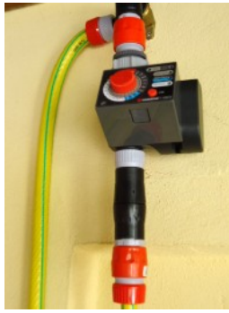
Programmatore montato in luogo inaccessibile su gomito a placca
