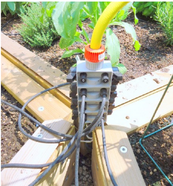
Moduli distributori accoppiati e alimentati dall'alto distribuiscono l'acqua ai tubi capillari
