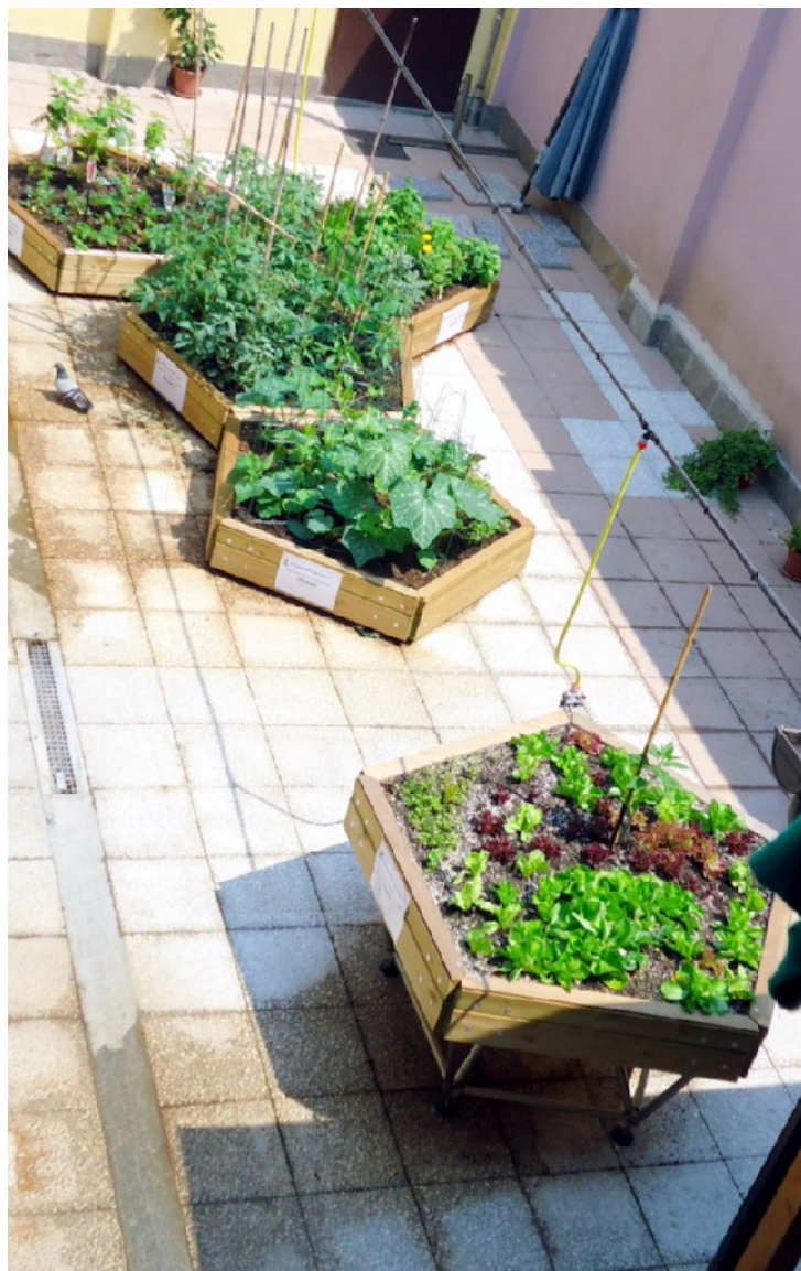
La rete portante dell'irrigazione sospesa ad un cavo alimenta dall'alto i moduli distributori.
